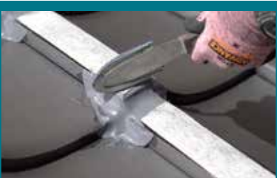
④シーリング材充填(段差部)
