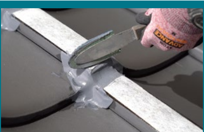
④シーリング材充填（段差部）
