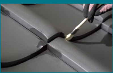
①プライマー塗布（シーリング用）
