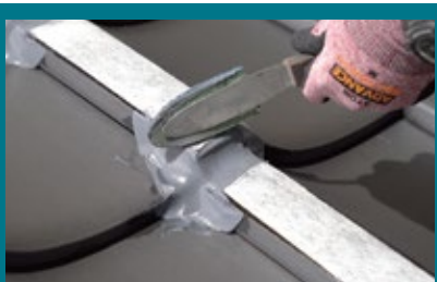
④シーリング材充填（段差部）
